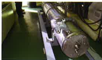
ハウステンボス向MHタンク Hydrogen Storage Tanks for Huis Ten Bosch
