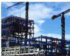
短期間で移動する 工事現場の動画監視に
